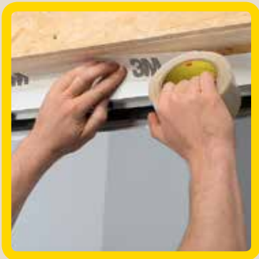
Lufttätning mot takfönster. FAST-G
