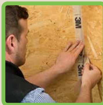
Lufttätning av klimatskal. FAST-F
