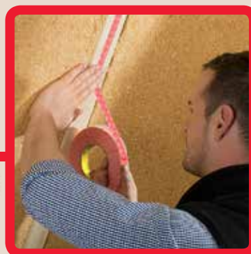
Lufttätning och direktmontering av folien mot träregel/ståregel. FAST-D
