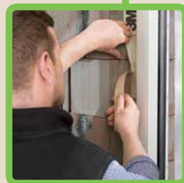
Delat skyddspapper för enkel montering av lufttäta anslutnin- gar runt dörrar. FAST-F
