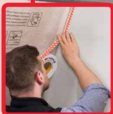
Fäster enkelt ångspärren mot putsade ytor. FAST-D
