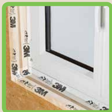
Delat skyddspapper för enkel montering av lufttäta anslutningar runt fönster. FAST-F
