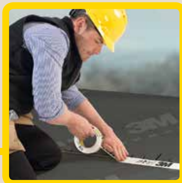
Lufttätning, skarvning och överlappning av takpapp. FAST-G
