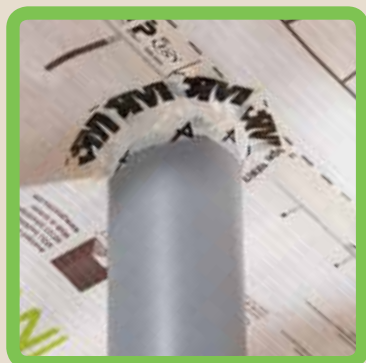
Lufttätningar av genomfö- ringar och anslutningar. FAST-F
