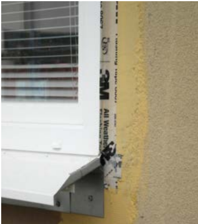
Utvändig lufttätning av fönster med 3M All Weather Flashing Tape 8067
